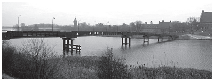
Rys. 1. Widok kładki od strony południowej. Fot. Agata Pawelec
